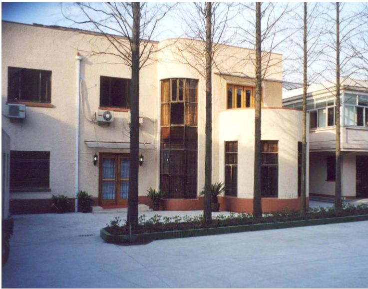
原将军府楼，于1999年改为市临检中心行政楼（摄于2004年1月）
